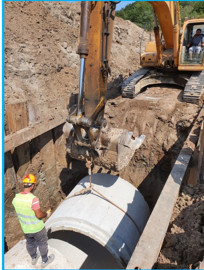
Nilüfer İlçesi, Çaylı Mahallesi Kanalizasyon Çalışması
